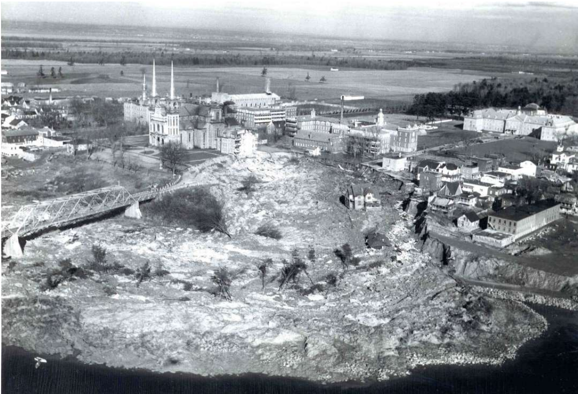
Figure 1 : Vue d'ensemble du glissement de terrain de 1955. Notez, sur le côté droit de la photo, le chemin menant au pied de la berge, caractérisé par une pente très abrupte. L'enrochement précédemment installé à la base de la berge est visible à l'extrémité des débris, sur le côté droit de la photo. (Source : Gouvernement du Québec)
