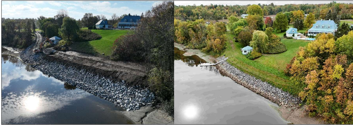
Figure 13 : Travaux de stabilisation en face de la rue des Brumes, sur la rivière Batiscan. À gauche : en cours de réalisation. À droite : 11 mois après la fin des travaux.
