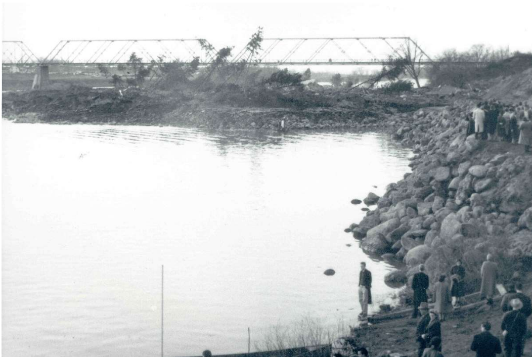
Figure 17 : Enrochement en amont du site et débris du glissement de terrain. (Source : Ministère des Transports et de la Mobilité durable)
