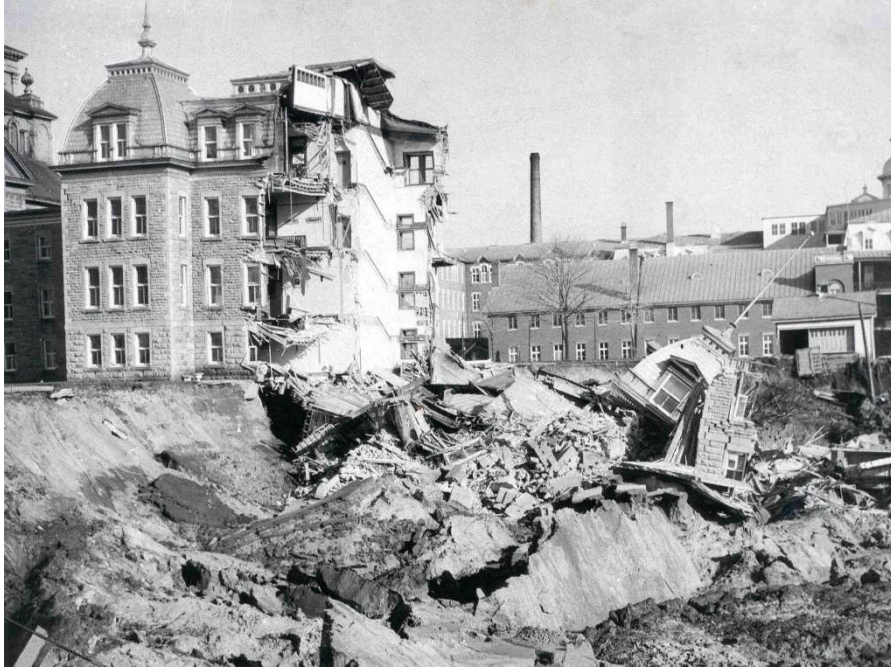
Figure 8 : L'évêché partiellement détruit par le glissement de terrain. Notez la présence d'un pinacle en bas à droite sur la photo révélant la composante d'étalement du glissement. (Source : Ministère des Transports et de la Mobilité durable)
