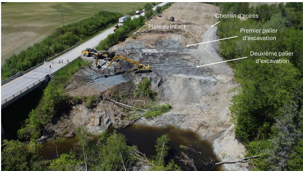
Figure 7 : Excavation de paliers de sol en s'approchant progressivement de la cicatrice du glissement. Le chemin d'accès a été placé à un endroit où il se trouvait plus bas que le plateau intact adjacent. (Source : MTMD – DGG)
