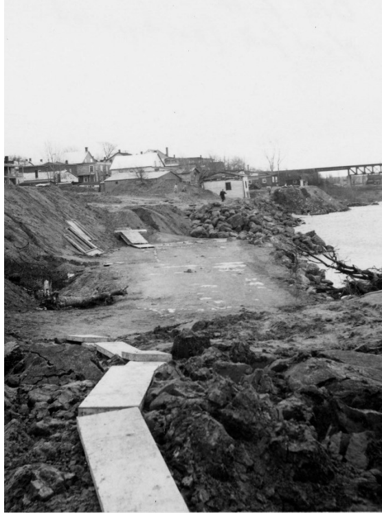
Figure 16 : Travaux en cours: enrochement à la base du talus ou déblais dans la pente. (Source : Ministère des Transports et de la Mobilité durable)
