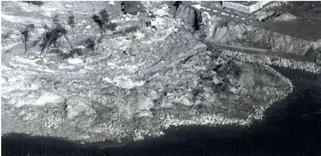
Figure 18 : Enrochement emporté par le glissement et déblai dans le talus pour la construction d'une protection contre l'érosion. (Source : Gouvernement du Québec)
