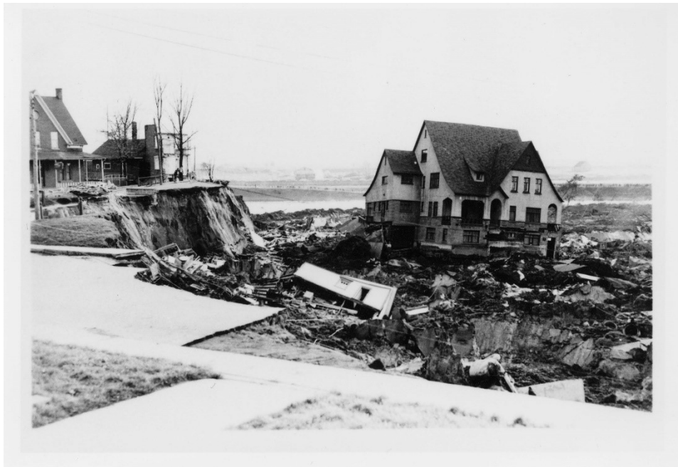
Figure 5 : Une maison construite sur une dalle a glissé sur les débris et est demeurée intacte. (Source : Appartenance Mauricie, 3042-074)
